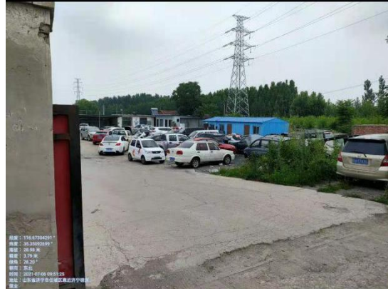
图2-4 110kV海井线/110kV海煤线13#~14#之间，线下汽车修理厂
