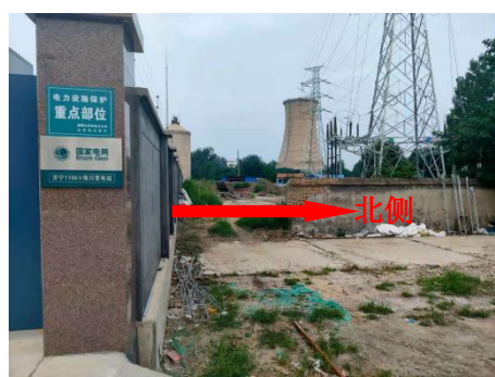
图 4-6 海川 110kV 变电站北侧
