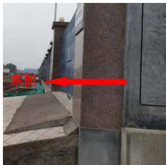
图 4-3 海川 110kV 变电站东侧
