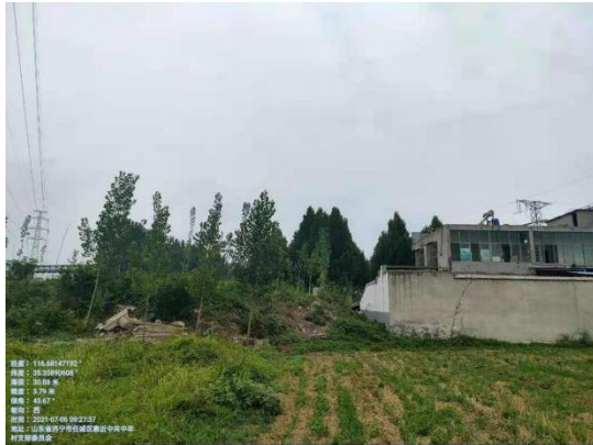
图2-3 110kV海煤线7#~8#之间，线西北25m沿街房
