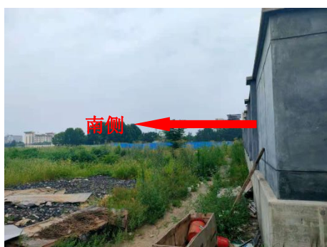
图 4-5 海川 110kV 变电站南侧
