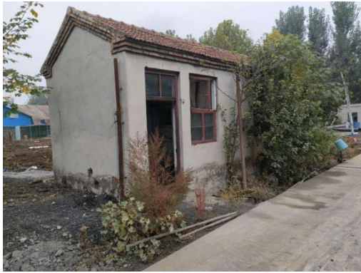
图2-1 变电站西北侧21m废弃厂房看护房
