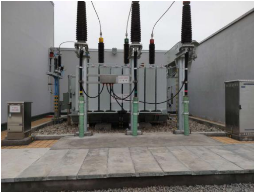
图 4-8 1 号主变压器
