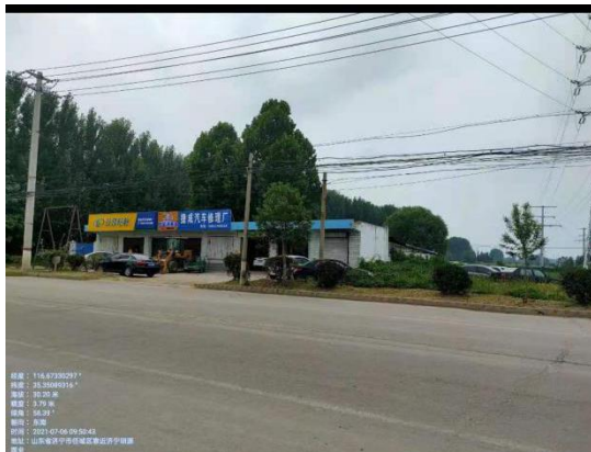
图2-5 110kV海井线/110kV海煤线13#~14#之间，线东5m汽车修理厂
