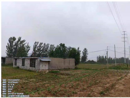
图2-2 110kV谷亭II线55#~56#之间，线西15m看护房
