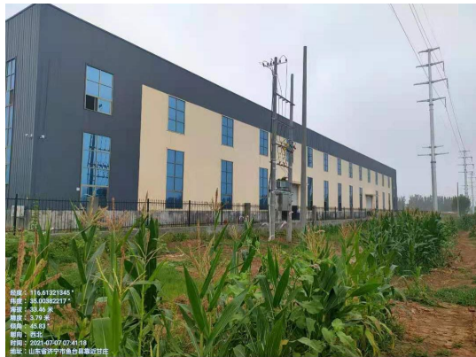
图2-3 110kV谷亭II线58#~60#之间，线西14m华毅纺织厂房
