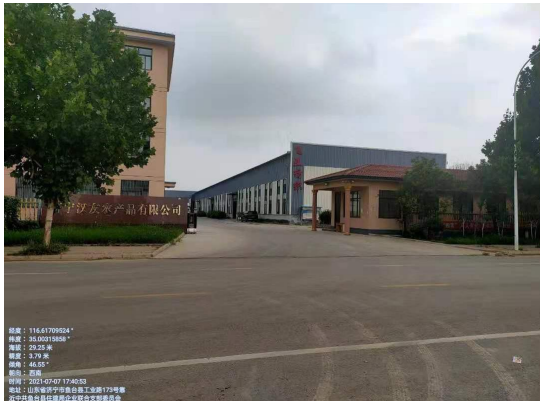
图2-7 110kV谷亭II线62#~63#之间，线东25m济宁汉友农产品有限公司门卫
