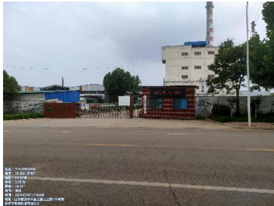
图2-9 110kV谷亭II线63#~65#之间，线东25m鱼台聚源有限公司门卫
