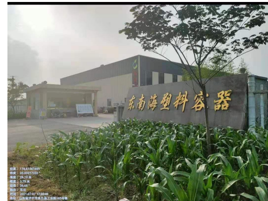
图2-6 110kV谷亭II线61#~63#之间，线西5.0m东海塑料容器门卫
