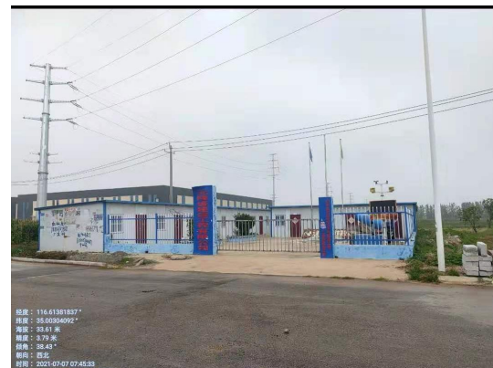
图2-4 110kV谷亭II线60#~61#之间，线西14m元隆盛建设工程有限公司
