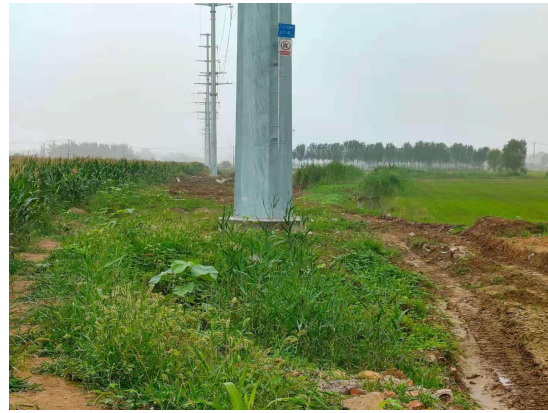
图6-2 塔基下方土地生态恢复
