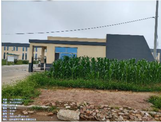
图2-1 110kV鱼唐线71#杆塔西北21.8m华毅纺织门卫
