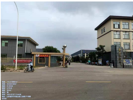
图2-5 110kV谷亭II线61#~63#之间，线东24.5m鲁星电气有限公司门卫及办公楼
