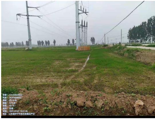
图6-1 电缆沟上方土地生态恢复
