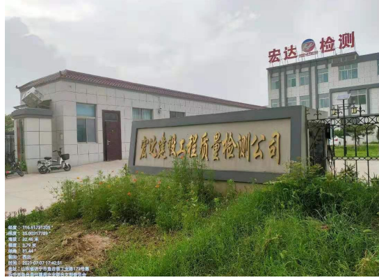
图2-8 110kV谷亭II线62#~63#之间，线西5m鱼台县宏达建设工程质量检测有限公司门卫
