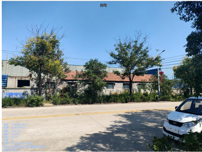
图 2-1 110kV 留庄变电站北侧 25m 新耀公司
