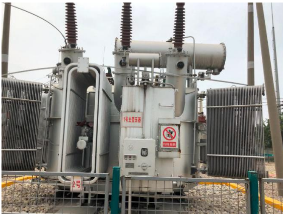
图 4-7 1#主变压器
