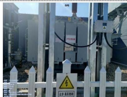
图 4-8 2#主变压器
