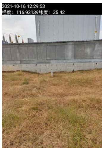
图 7-5 110kV 罗中线/110kV 彦厂线中心店分支双回电缆线路路径空地
