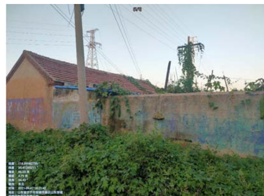
图2-4 110kV罗中线/110kV彦厂线中 心店分支16#~17#之间，线南16m大乐 章村民房
