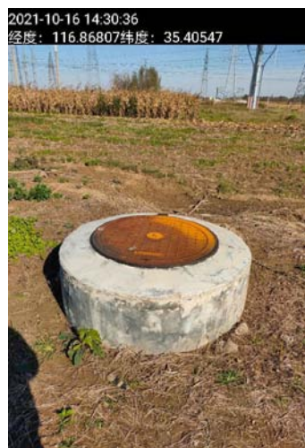
图 7-6 110kV 罗中线单回电缆段线路路径空地
