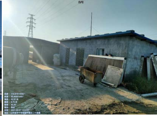
图2-2 110kV罗中线/110kV彦厂线中 心店分支4#~5#之间，线南10m二十里 铺村东看护房
