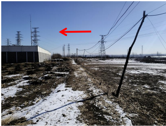
图 4-9 盘阳 220kV 变电站东侧
