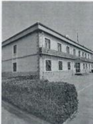
图 5 泉河站内部，办公楼
