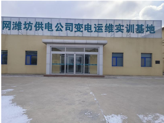
图 2-1 泉河站内部，供电公司运维实训基地
