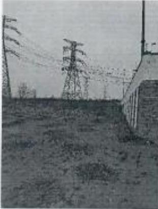
图 13 潍坊盘阳 220kV 变电站西侧
