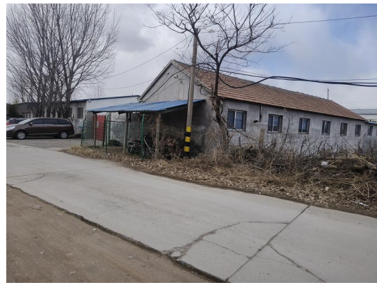
图 2-4 泉河站北侧 20m，民房 1
