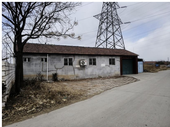
图 2-5 泉河站北侧 40m，民房 2
