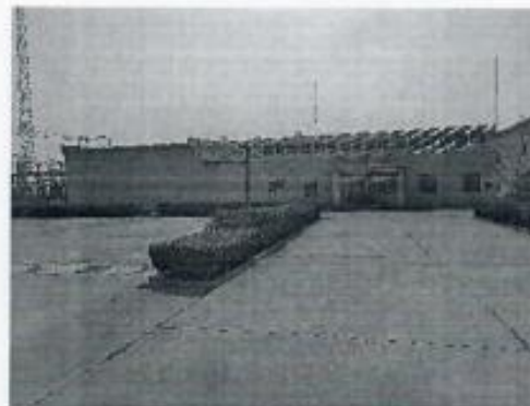
图 6 泉河站内部，供电公司运维实训基地
