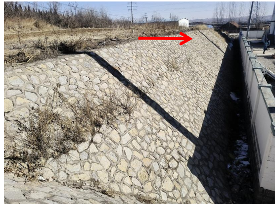
图 4-12 泉河 220kV 变电站北侧
