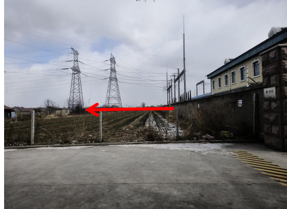
图 4-6 泉河 220kV 变电站北侧
