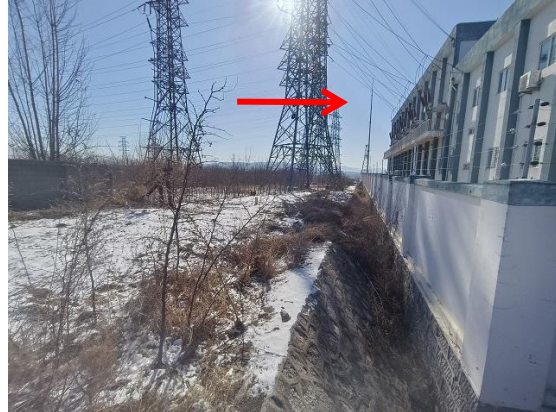
图 4-10 盘阳 220kV 变电站南侧
