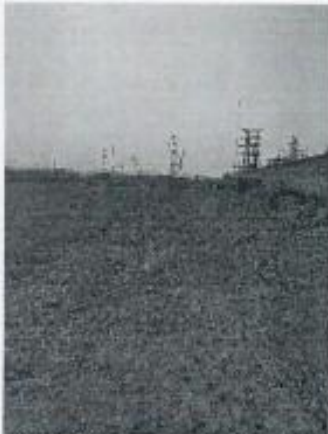
图 3 潍坊泉河 220kV 变电站东侧
