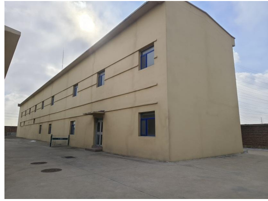
图 2-2 泉河站内部，供电公司运维实训基地宿舍
