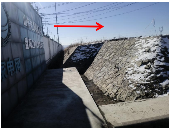
图 4-11 泉河 220kV 变电站西侧
