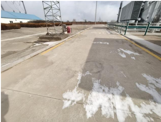
图 6-3 变电站内路面硬化
