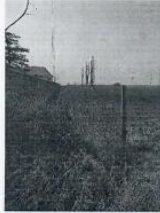
图 4 潍坊泉河 220kV 变电站西侧
