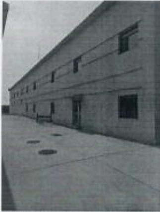
图7 泉河站内部, 供电公司运维实训基地宿舍
