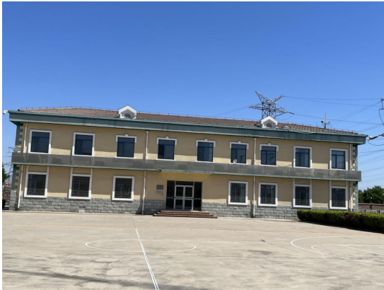
图 2-3 泉河站内部，办公楼
