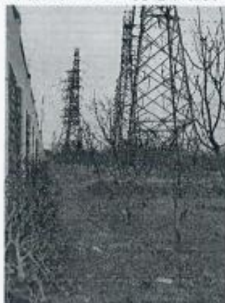
图12 潍坊奎阳220kV变电站东侧
