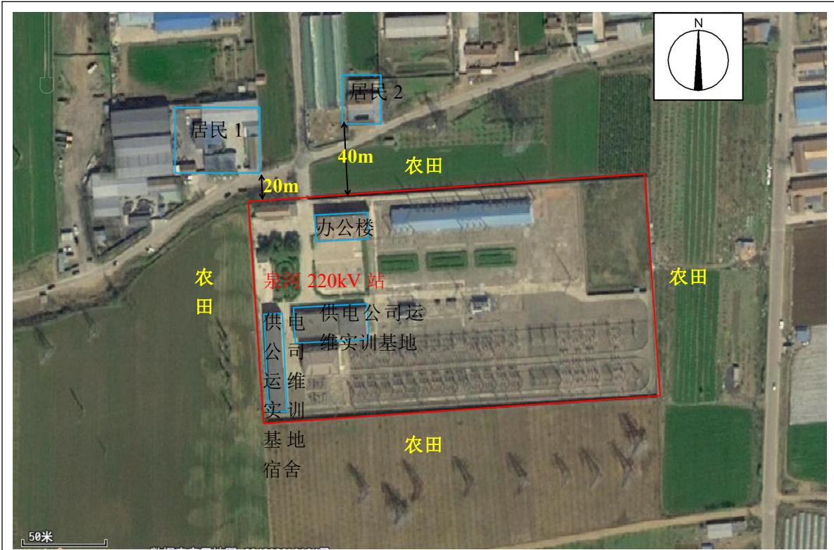
图 4-2 泉河 220kV 变电站周围关系影像图
