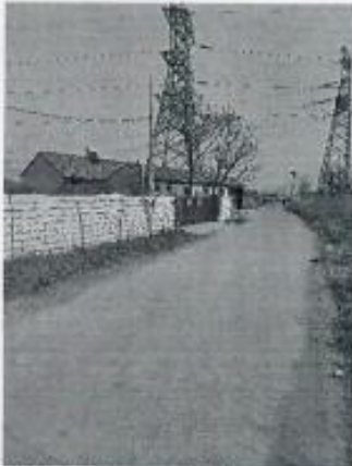
图9 泉河站北侧40m, 民房2
