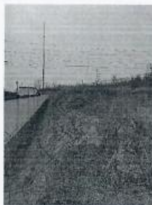
图10 潍坊奎阳220kV变电站北侧
