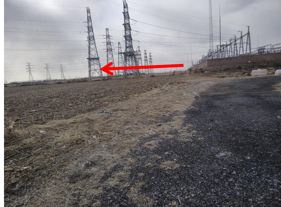
图 4-4 泉河 220kV 变电站南侧
