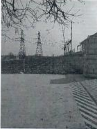
图 1 潍坊泉河 220kV 变电站北侧
