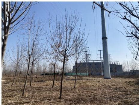
图6-3 牵张场用地恢复情况
