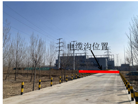
图6-2 变电站周围电缆沟恢复情况
