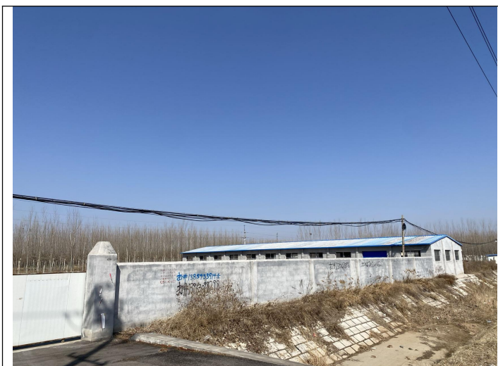
图 2-1 110kV 支渡线 42-43#线下养殖场看护房
