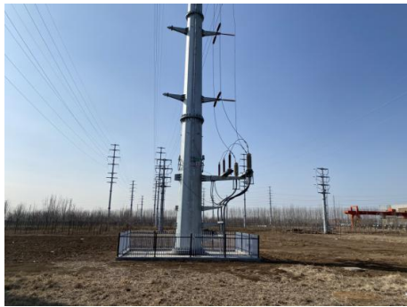
图6-1 塔基周围恢复情况
