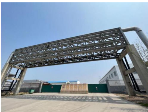
110kV唐灰乙线河口67#~66# 线东23m青岛鑫佳源公司
