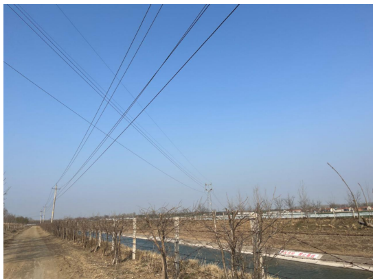
图 6-11 一档跨越胶东地区引黄调水工程平度市段（22#~23#塔基）
