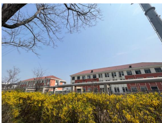
110kV唐灰乙线河口71#~70# 线东25m青岛新泰和能源材料有限公司
