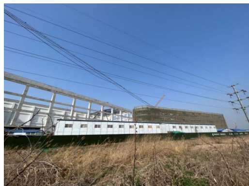
图 2-8 110kV 唐灰乙线河口 59#~56# 线东北 24m 蔡家村东北施工板房
