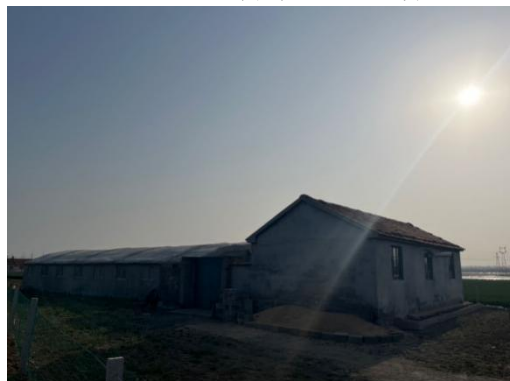
110kV唐灰乙线河口21#~20# 线南16m庚家村北养殖看护房
