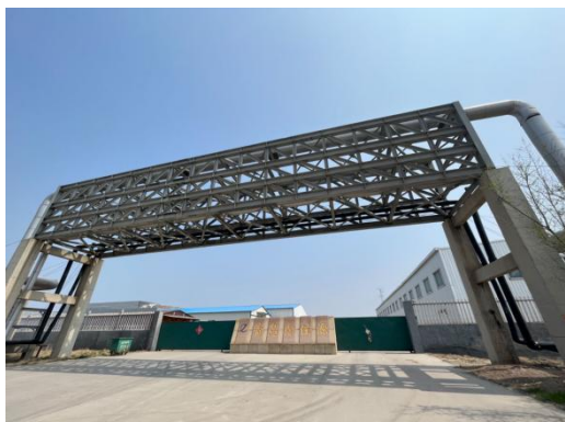
图 2-7 110kV 唐灰乙线河口 67#~66# 线东 23m 青岛鑫佳源公司
