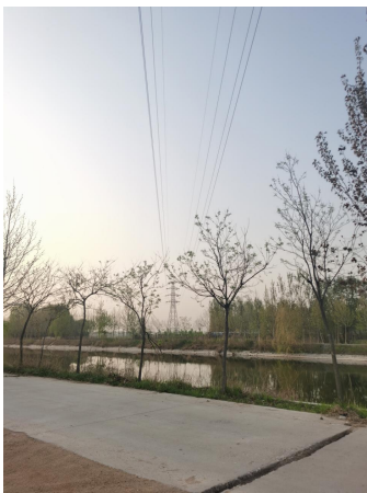
图 6-9 一档跨越淄阳河（41#~42#塔基）
