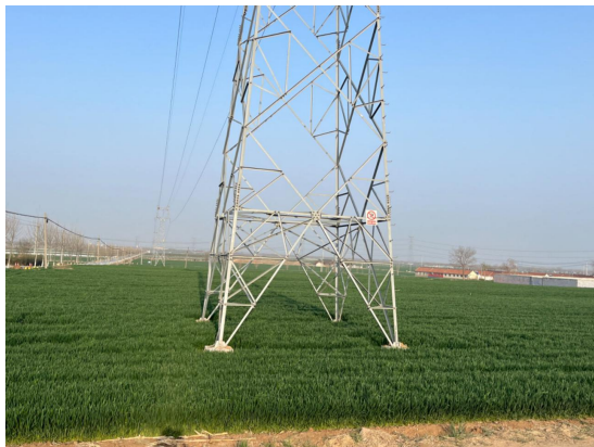
图 6-1 塔基周边恢复
