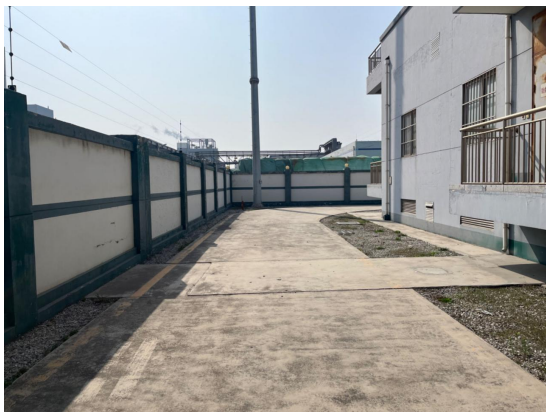
图 6-5 变电站内路面硬化
