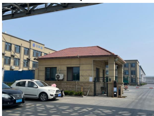
图 2-5 110kV 唐灰乙线河口 68#~67# 线东 18m 青岛众硕新能源科技有限 公司
