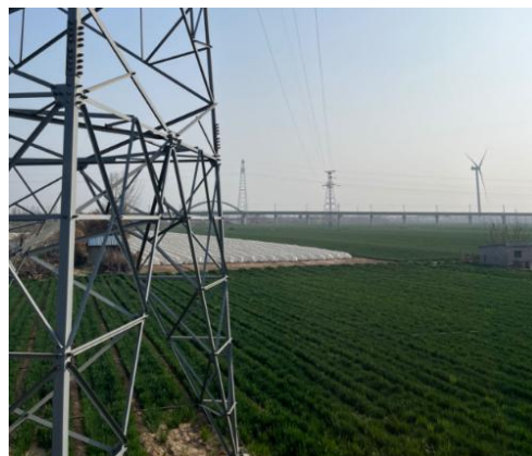
图 6-12 牵张场恢复情况
