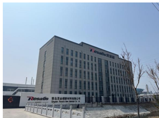
图 2-4 110kV 唐灰乙线河口 69#~68# 线东 30m 青岛昱金硒新材料有限公司
