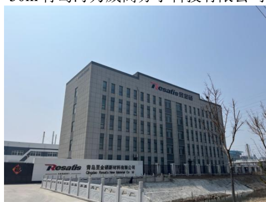
110kV 唐灰乙线河口 69#~68#线东 30m 青岛昱金晒新材料有限公司
