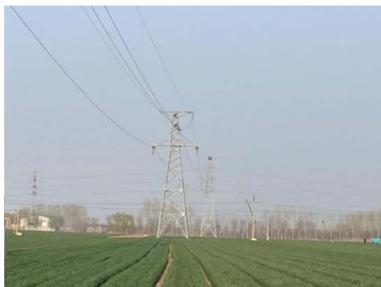
图 6-13 施工道路恢复情况
