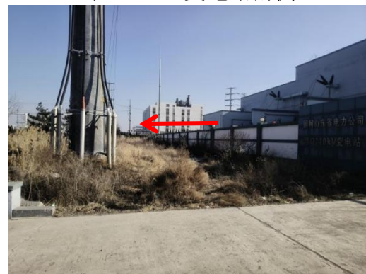
河口110kV变电站北侧
