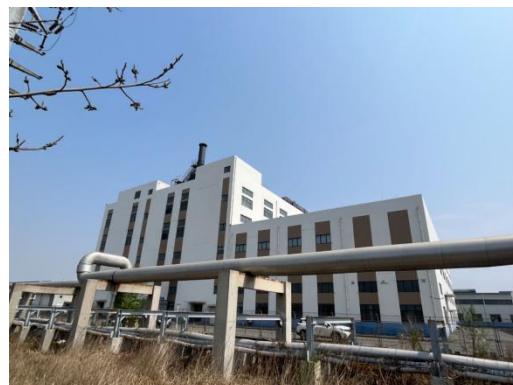
图 2-2 110kV 唐灰乙线河口 73#~72#线 东 30m 青岛海力威高分子科技有限公司
