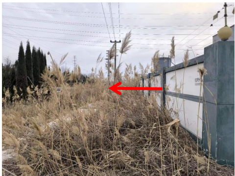
图 4-3 河口 110kV 变电站东侧
