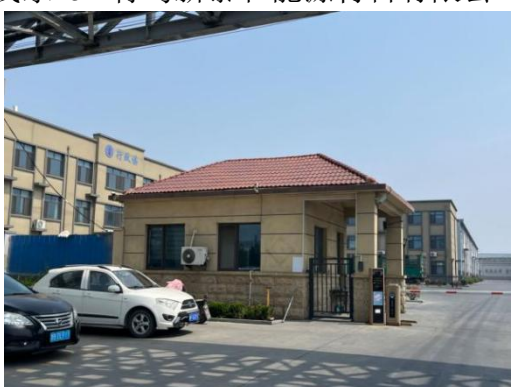
110kV唐灰乙线河口68#~67# 线东18m青岛众硕新能源科技有限公司
