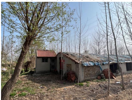
图 2-9 110kV 唐灰乙线河口 42#~41#线东 30m 独埠陈家村西养殖看护房
