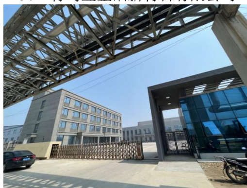
110kV唐灰乙线河口68#~67# 线东21.5m建业科技公司
