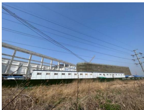
110kV唐灰乙线河口59#~56#线东北 24m綦家村东北施工板房
