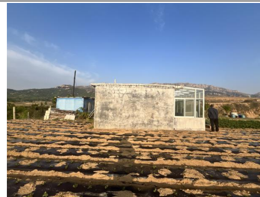
图2-9 220kV秦河I、II线34-35#线东5m龙王 沟村看护房
