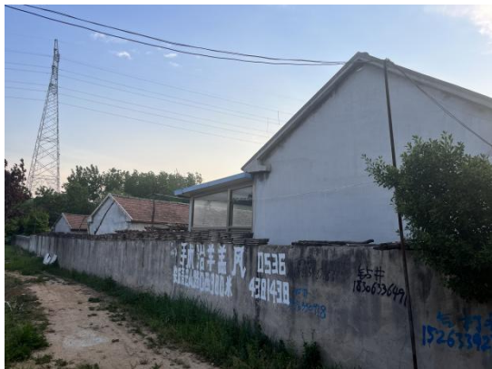
图2-13 220kV秦河I、II线50-51#线东北35m 下石河村民房
