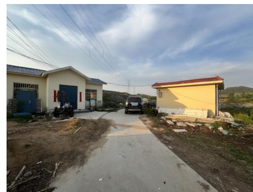
图2-12 220kV秦河I、II线44-45#线东5m东 石河村水库看护房
