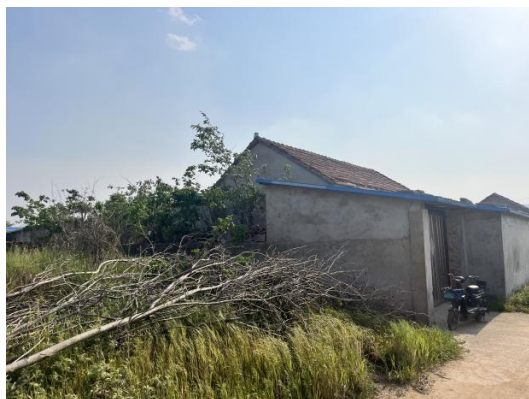
图2-7 220kV秦河I、II线19-20#线西南22m 大桃园村看护房1
