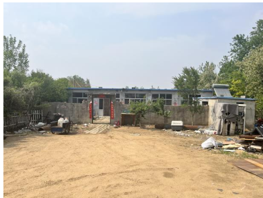
图 2-14 220kV 秦河 I、II 线 2-3#线北 35m 废品收购站看护房
