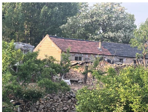
图2-11 220kV秦河I、II线37-38#线东5m王 家后沟村民房
