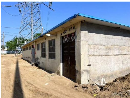
图2-1 220kV秦河I、II线北5m秦楼站北侧养殖看护房
