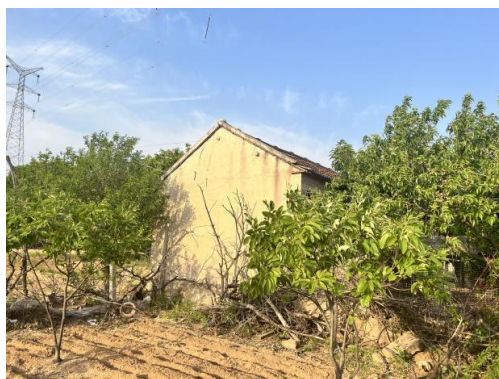
图2-10 220kV秦河I、II线35-36#线西5m上 坳村看护房
