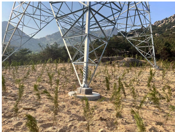
图 6-2 生态保护红线区内塔基用地复植 (220kV 秦河 I、II 线 26#)
