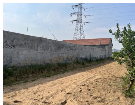
图2-6 220kV秦河I、II线12-13#线南36m汪家官庄村民房
