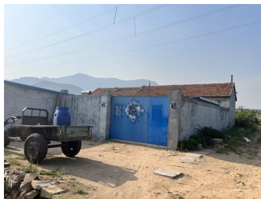
图2-8 220kV秦河I、II线20-21#线南20m大 桃园村看护房2
