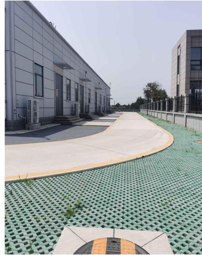
图6-6 变电站内路面硬化
