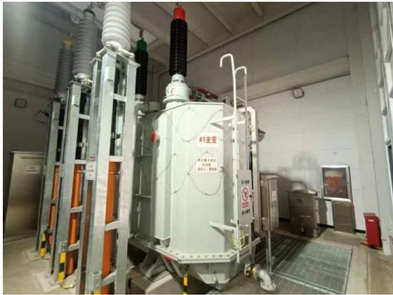
图 4-7 1#主变压器
