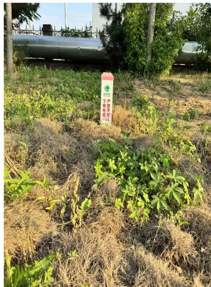
图6-8 电缆沟上方用地平整
