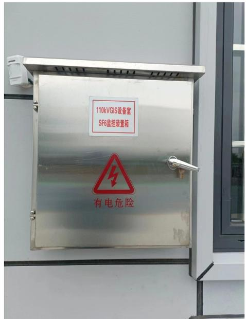
图6-4 SF<sub>6</sub>泄露报警仪
